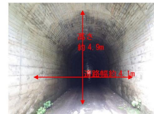
トンネル内部はコンクリートで保護している
