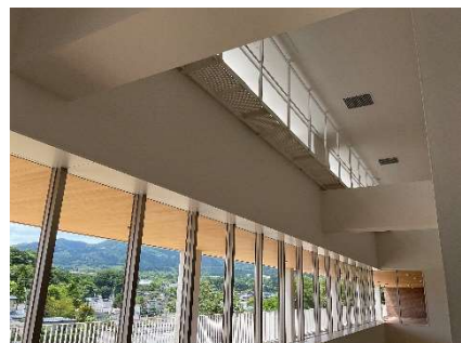
自然採光窓（南部町庁舎）
