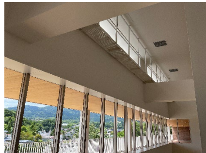
自然採光窓（南部町庁舎）
